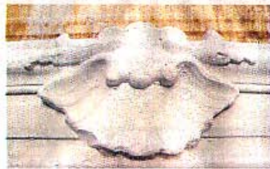
STUKATÖRARBETE. Linnés nya öppna spis kröns av en snäcka. Spisen skall ha samma avnötningar och skavanker som originalet.
